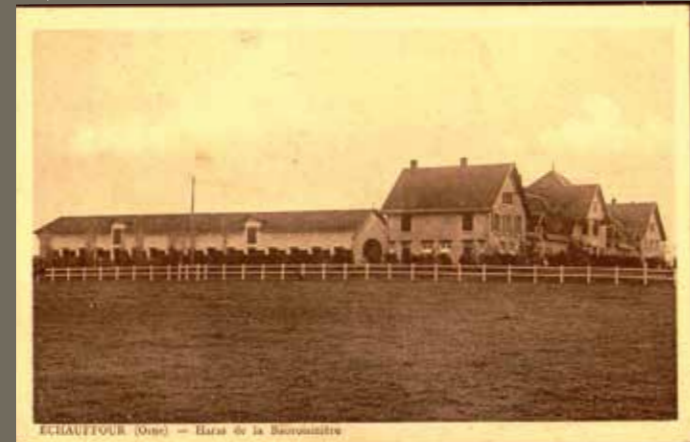
Haras de la Beauvoisière (Arch. dép. Orne, ZFICP150/047)
